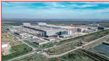
Draufsicht auf die Produktionswerkstatt der Fabrik
