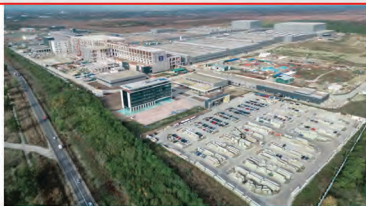
Draufsicht auf den Bürobereich
